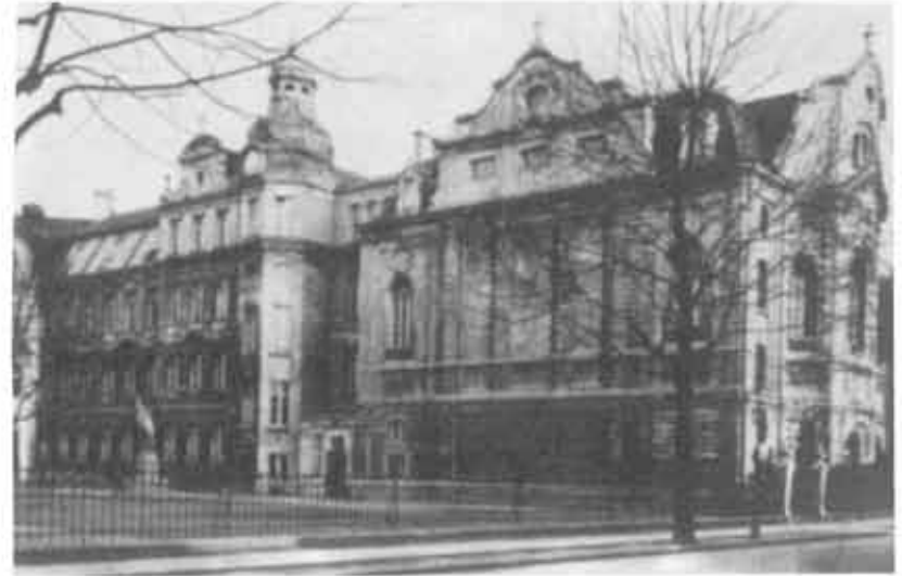
Städtisches Reform-Realgymnasium mit Realschule an der Rethelstraße Architekt Baurat Radke
