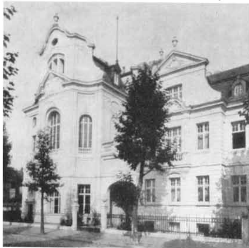
Aula-Gebäude und Direktor-Wohnhaus, von der Rethelstraße aus gesehen
